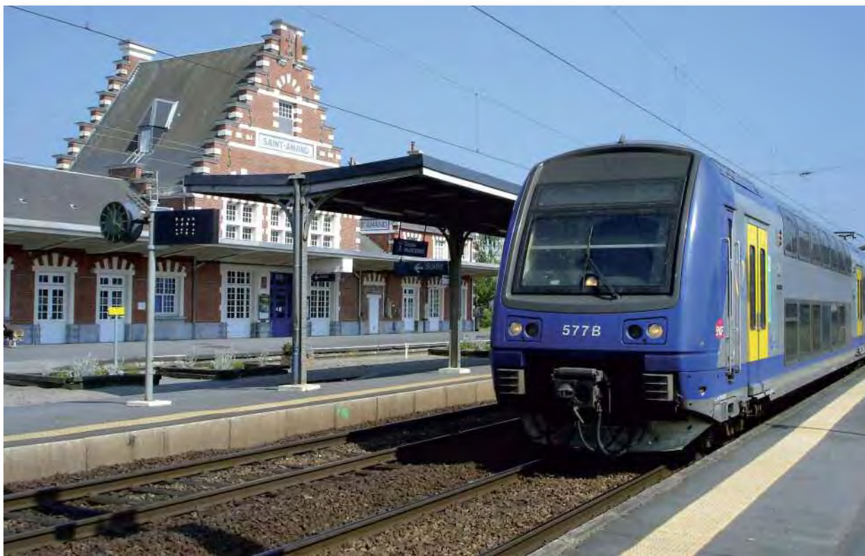
Gare de Saint-Amand-les-Eaux (Nord) © Cete Nord-Picardie - Cyprien Richer
