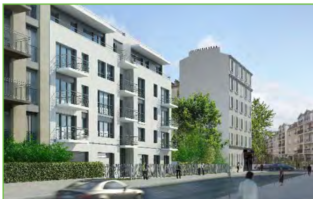
Source : DTACC Architecture / Façade immeuble habitations
